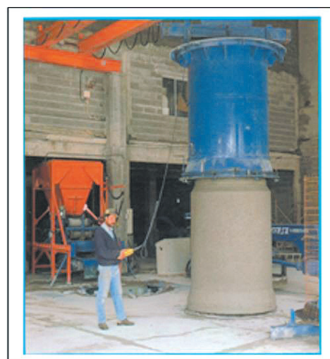
4 - Retirada do molde externo do tubo
