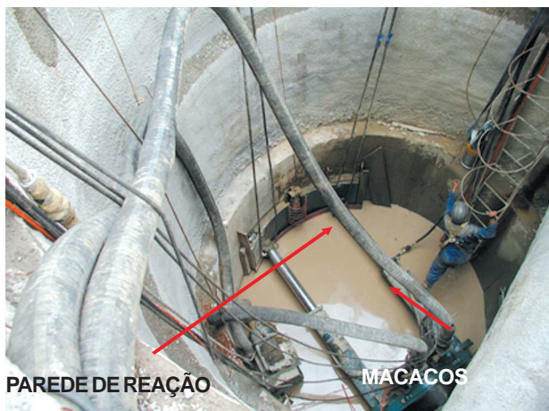
FIGURA 10.10 - Macaco para cravação dos tubos
