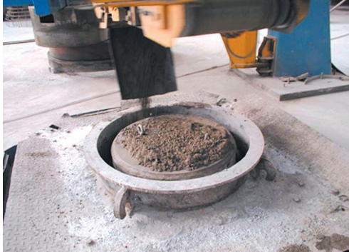
FIGURA 6.4 - Vista do enchimento do molde para fabricação do tubo
