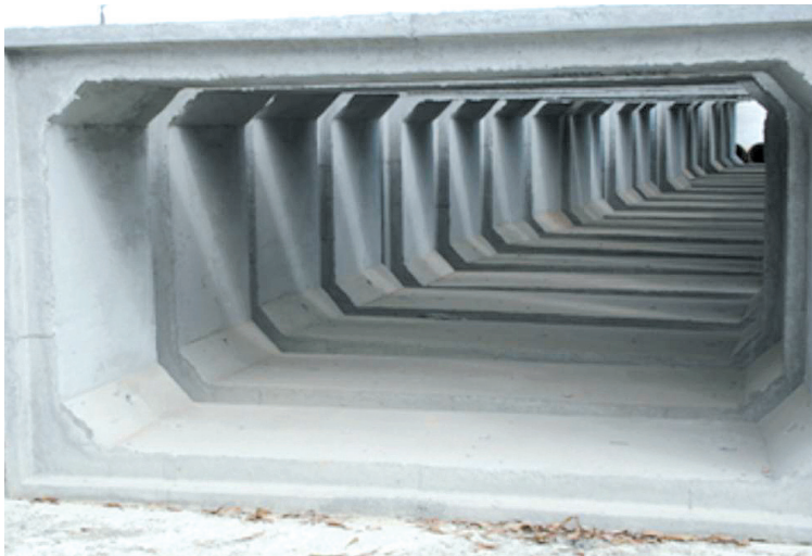
FIGURA 8.5 - Galerias celulares de 3,00 x 1,50 metros
