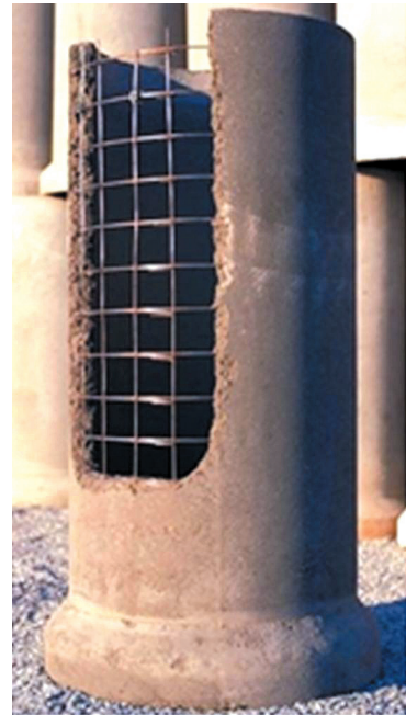
FIGURA 5.31 - Tela de aço utilizada em tubos de concreto para esgoto
