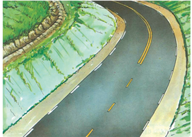
FIGURA 11.3 - Valetas não Revestidas
