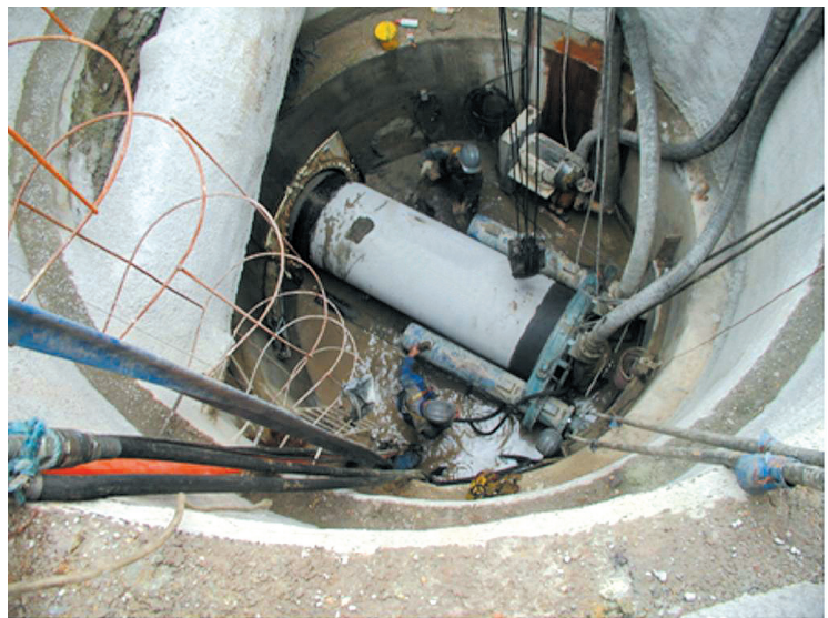
FIGURA 10.12 - Processo de cravação dos tubos
