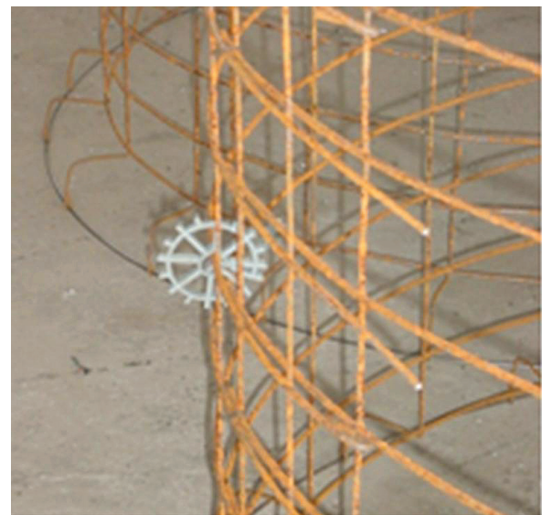
FIGURA 5.41 - Espaçador utilizado em uma armadura destinada para a produção de um tubo de concreto
