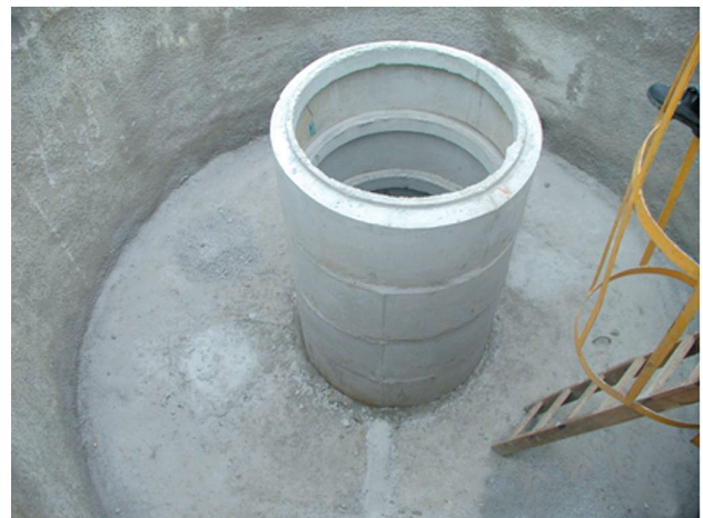
FIGURA 10.9 - Transformação dos poços de serviço em poços de visita
