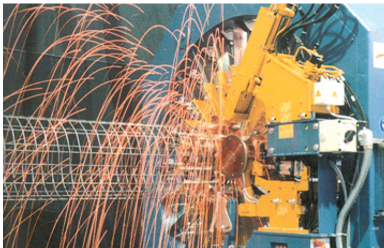
FIGURA 5.28 - Produção de armadura para tubos de concreto através de equipamento específico de soldagem
