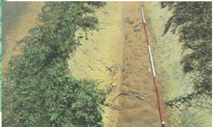
FIGURA 11.11 - Assoreamento
