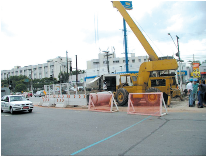
FIGURA 10.11 - Descida dos tubos nos poços
