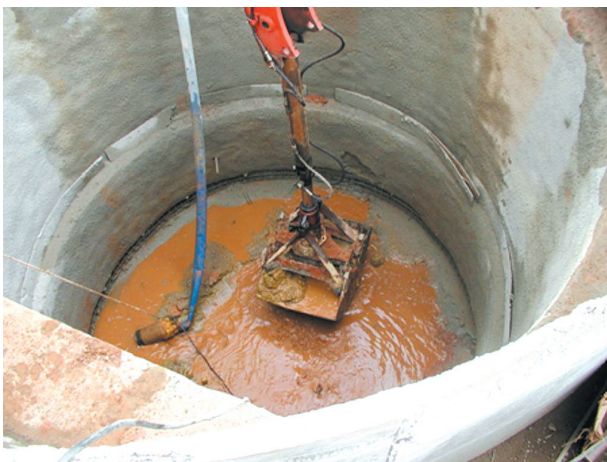
FIGURA 10.8 - Construção de poços de serviço
