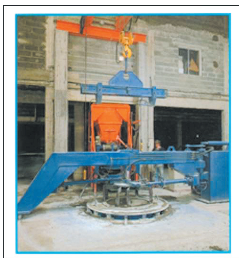
3 - Processo de compactação do tubo
