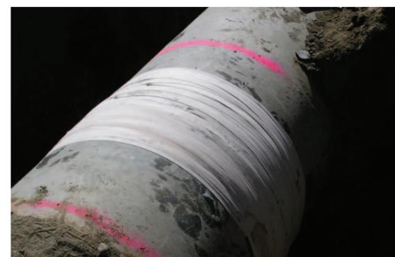
Um dos empreiteiros colidiu com um encanamento de água de 300mm no novo prédio da prefeitura. Ele deixou um arranhão no tubo de 300mm, cerca de 2/3 da espessura do tubo, mas não exatamente o perfurou.
