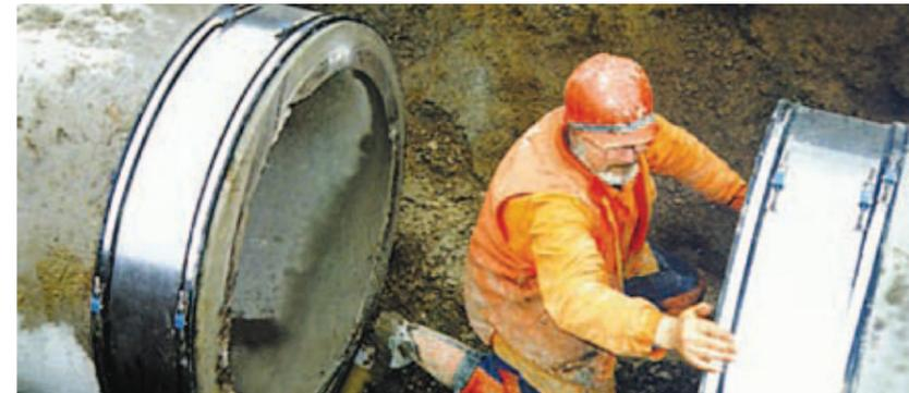
São acoplamentos ideais para consertos, alterações ou reabilitações de tubos de esgoto de grandes diâmetros. Estes acoplamentos são fabricados em PVC flexível oferecendo fácil instalação e conexões livres de vazamentos. Foram desenvolvidos para serem usados em todos os materiais de tubos de esgotos: cerâmica, concreto e ferro dúctil, fibrocimento, plástico ou fibra de vidro.
