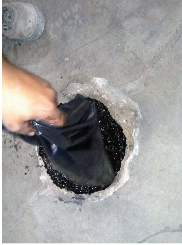
Preenchimento do buraco
