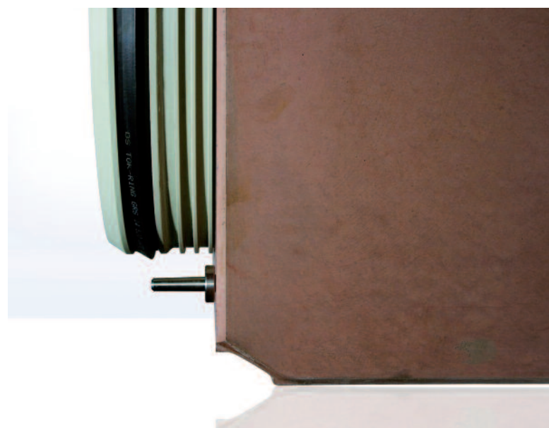
Uso de parafusos de aço para absorver cargas de cisalhamento
